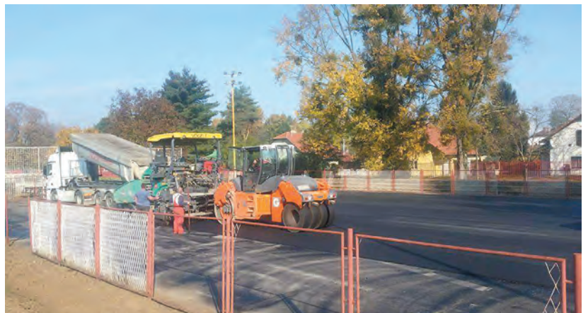
Rukometno igralište ima novi asfaltni sloj, a uskoro će dobiti i novu ogradu
