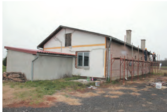
Započeli su radovi na obnovi prostorija NK-a Gat
