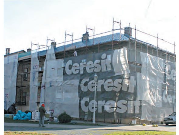
Postavljanjem termoizolacije i fasade, radovi na energetska obnovi zgrade bit će završeni
